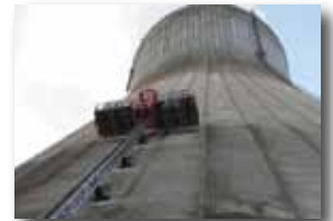
La División Motorizada dedicada de Safway tiene la respuesta de acceso a una variedad de sus necesidades de acceso a calderas.
